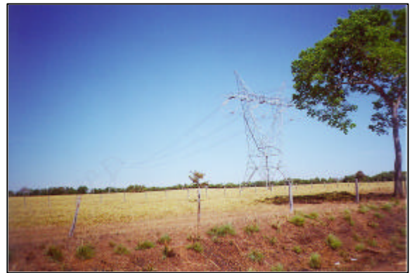
Gurupi – Vista da linha de transmissão em 500 kV da Interligação Norte-Sul.
